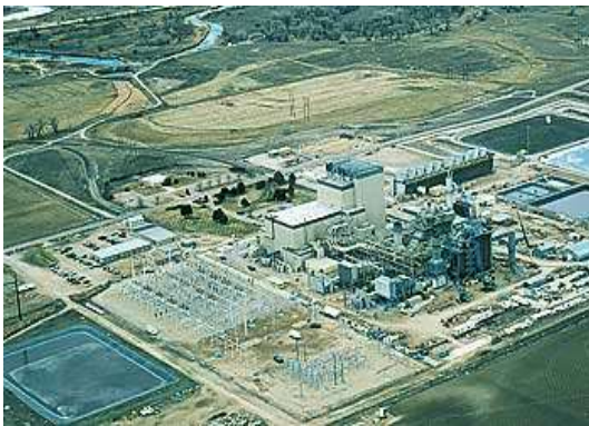
Fort Saint-Vrain, US 300 MWe 1976-89
